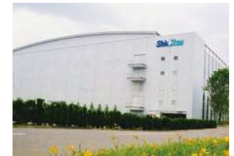
300mmウエハー棟 (信越半導体白河工場)
