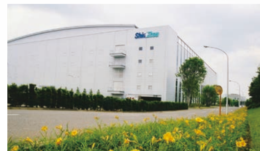
300mmウエハー棟(信越半導体白河工場)
