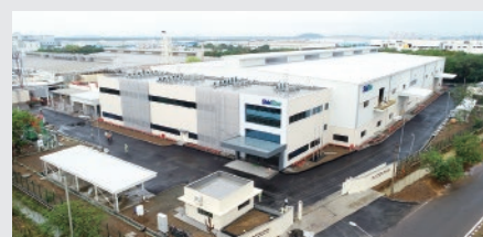
完成した第三棟
