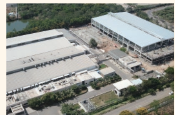
第3棟 (写真右側) の増設が進む 信越ポリマーインド社
