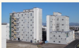
完成したメトロース®の新工場
