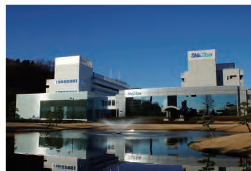
シリコン電子材料技術研究所(群馬県) 新棟(左側)
