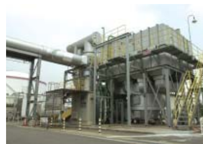
排ガス処理設備
