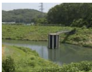
白河工場の水処理設備
