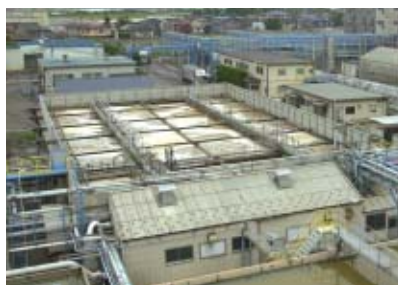
排水処理設備
