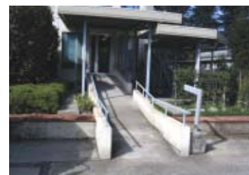
スロープの設置でバリアフリー化
