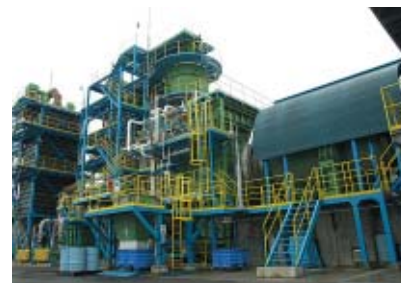
廃棄物処理設備
