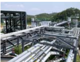
排水処理設備
