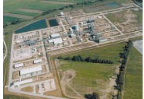
第一期工事が完成したシンテック ルイジアナ工場
