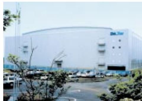
300mmシリコンウェーハ専用工場として新設された白河工場D棟
