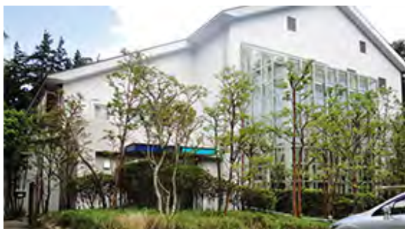
Shin-Etsu Chemical Hakone Shinsensou (Kanagawa prefecture)
