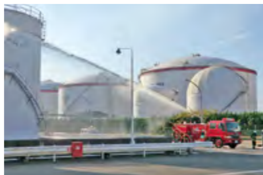
消防訓練(2011年10月 鹿島工場)
