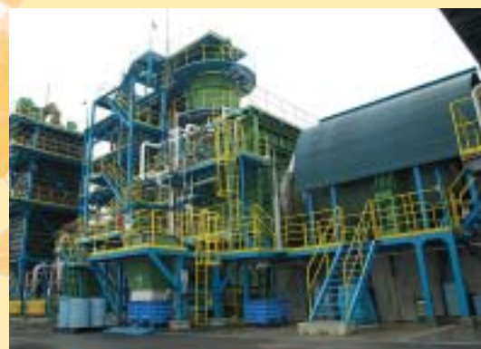
廃棄物処理設備
