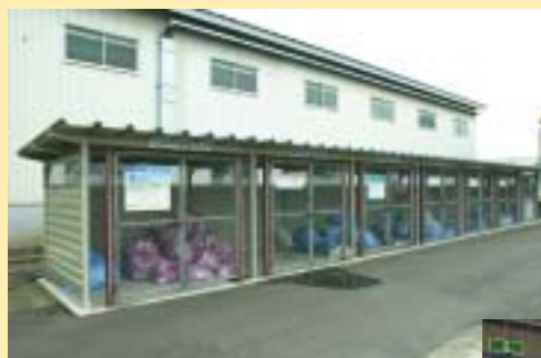
分別された廃棄物置場
