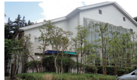
Shin-Etsu Chemical Hakone Shinsensou (Kanagawa Prefecture)
